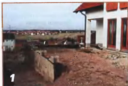
1 Площадку перед входом в дом пришлось выровнять.
