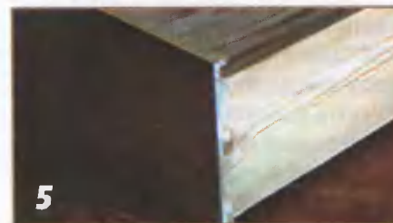
5 Задняя стенка неправильно прикреплена соединением «ласточкин хвост». «Качество» ящика налицо.
