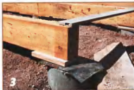
3 В качестве лаг применили брусья сечением 150x100 мм.
