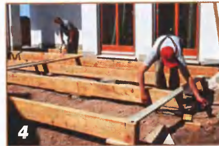
4 Все лаги надо выровнять по уровню с помощью подкладок.
